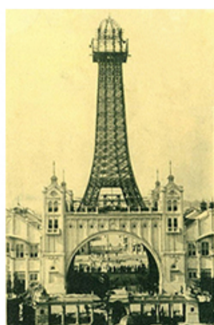
初代通天閣（明治45年～）昭和18年 火災で焼失
